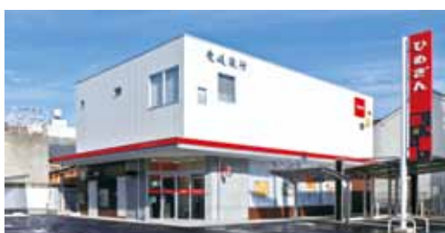
菊間支店 (平成23年11月28日 新築建替えオープン)
